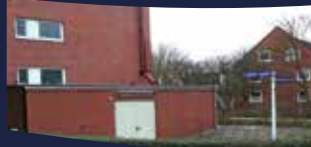
DAS NEUE BHKW IN DER LÜTTJE LEDGE
