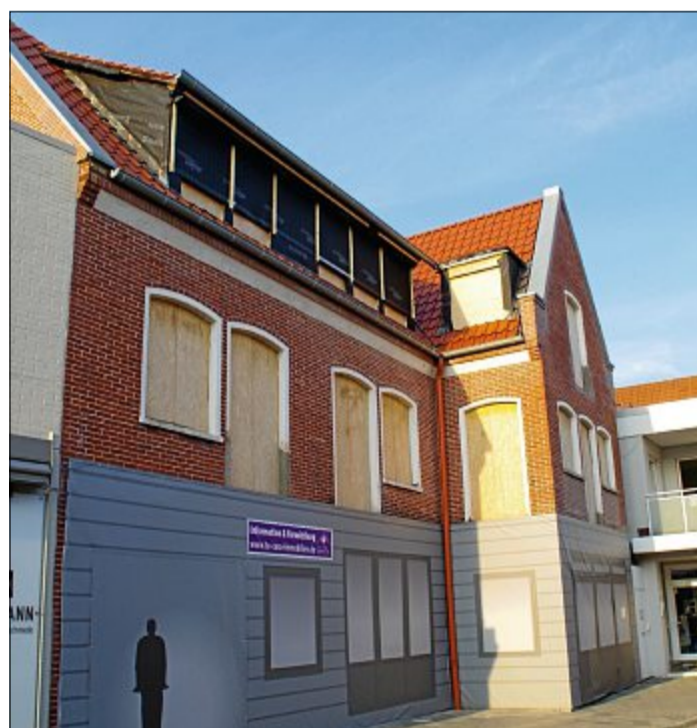
An der gut getarnten Baustelle in der Jann-Berghaus-Straße sollen die Arbeiten bald weitergehen. FOTO: LEIDIG
